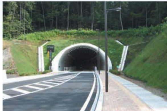
施工3ヶ月経過
