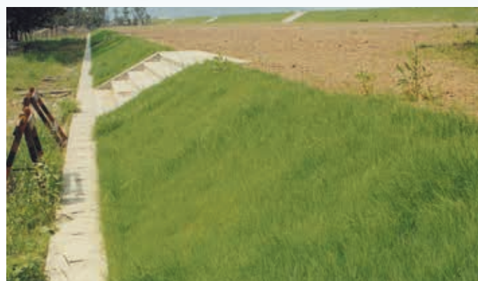
施工5ヶ月経過
