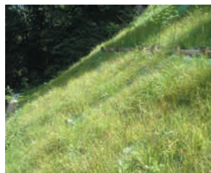
施工3カ月経過
