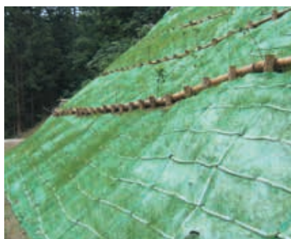
施工1カ月経過
