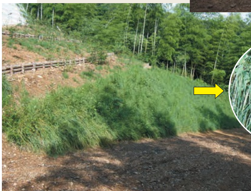
施工3ヶ月経過
